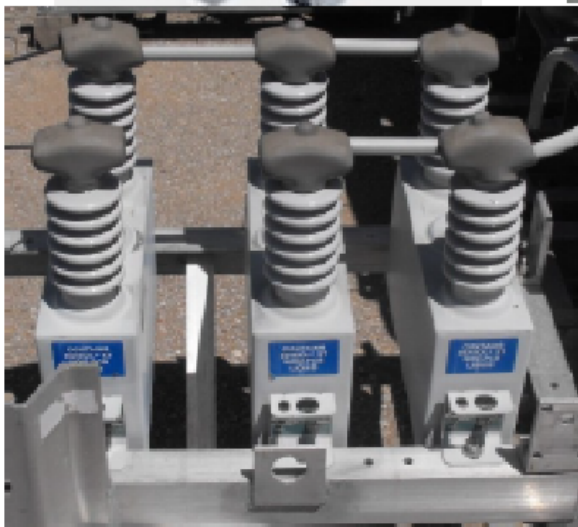
Capacitores de AT para regulação de Fator de Potência.
