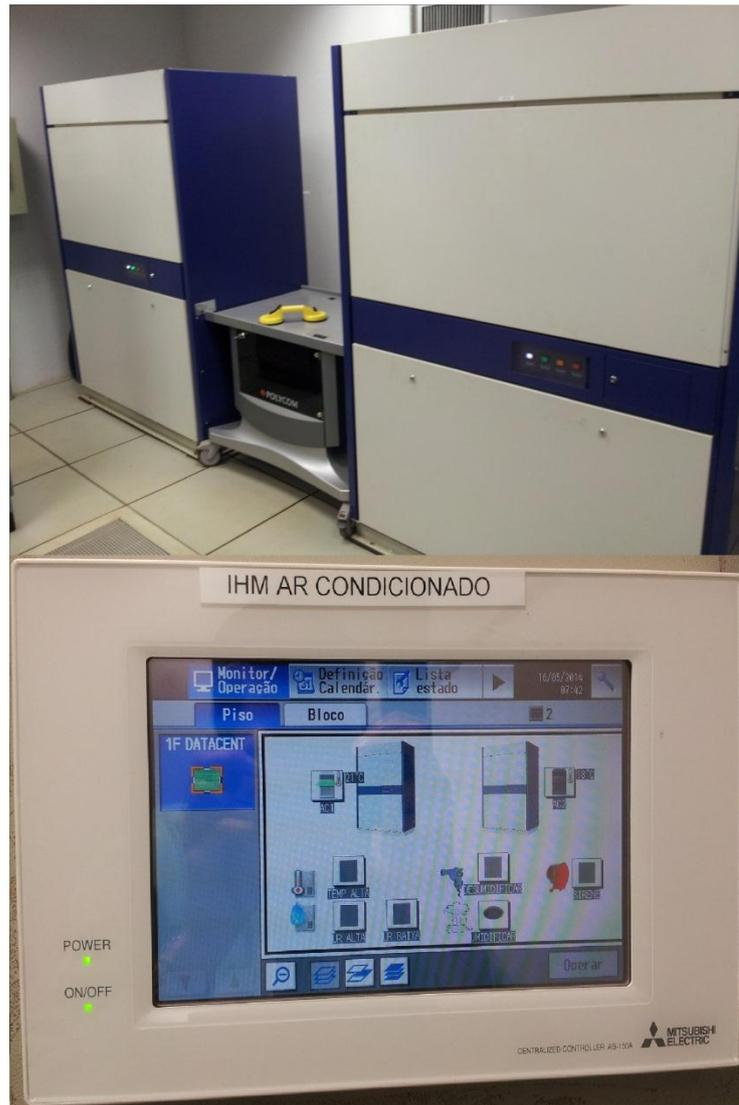
**Figura 3.11 – Sistema de refrigeração**
