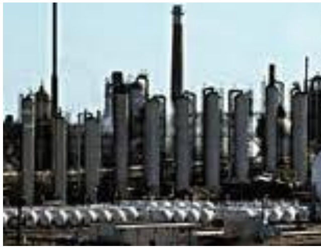
Colunas de destilação de uma refinaria
